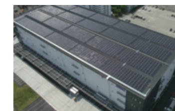
カネカ高砂物流センターに設置した太陽光発電設備
