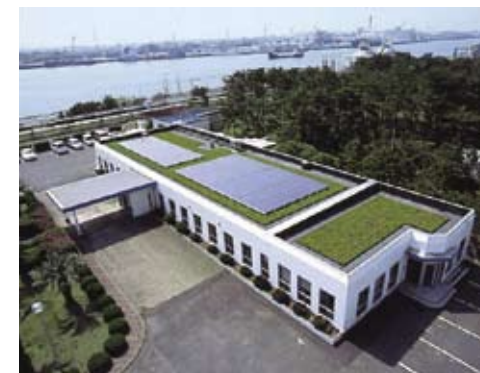
太陽電池で屋上緑化した当社鹿島工場事務所棟
