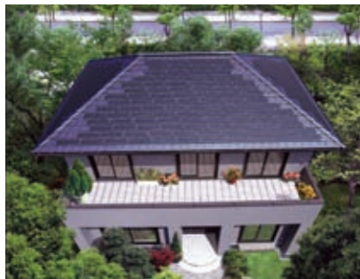
平板瓦一体型太陽電池の設置例
