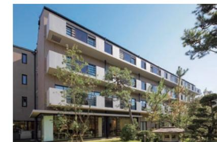
当社研修施設「カネカ未来創造館」の壁面に低反射太陽電池、手摺部には光を透過する薄膜シースルー太陽電池を設置
