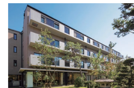
当社研修施設「カネカ未来創造館」の壁面に低反射太陽電池、手摺部には光を透過する薄膜シースルー太陽電池を設置
