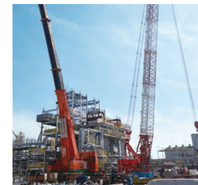
新規ガスタービンコージェネレーションの設置工事の様子
