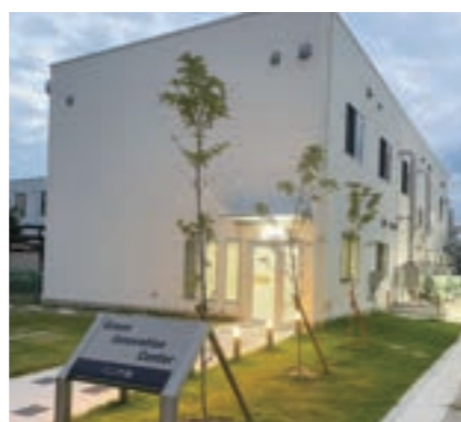
本研究開発にあたって新設したベンチ棟 (Green Innovation Center)
