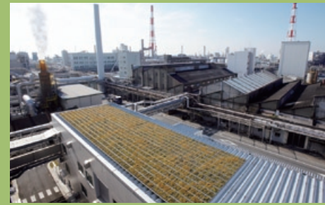
カネカロン生産工場の屋上では緑化も進めています
