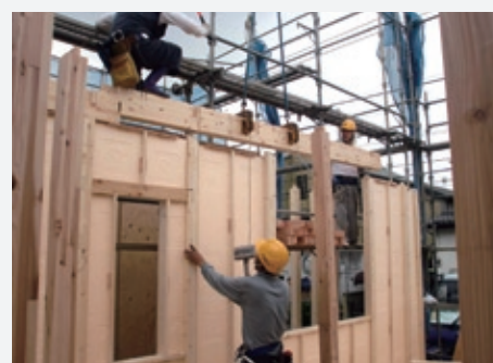
EPS断熱材の施工事例
