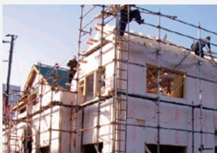
「カネライトフォーム」を断熱材として使用することにより、冷暖房を使用する時の電力使用量を削減します
