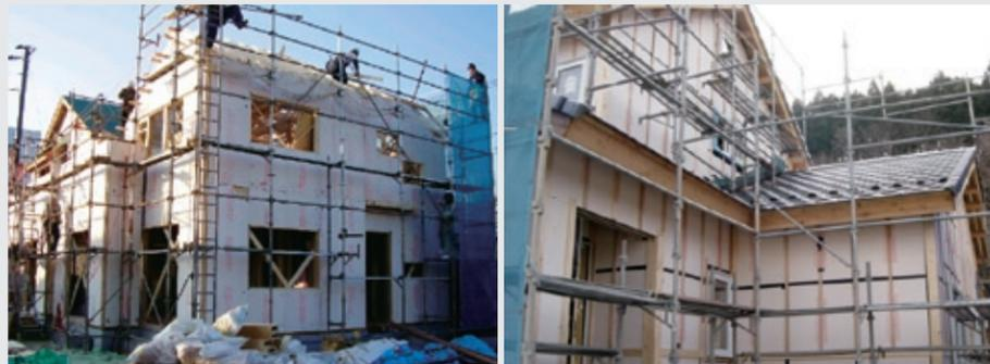
「カネライトフォーム」を断熱材として使用することにより、冷暖房を使用する時の電力使用量を削減します
