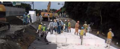
道路の拡幅の際にも活用されている
