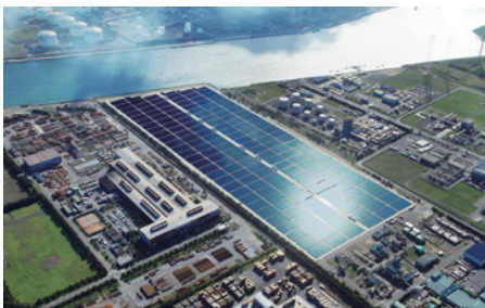
鹿島工場 西地区大規模太陽光発電所
