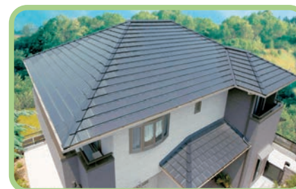
美しい屋根をコンセプトにした「瓦一体型太陽電池」
