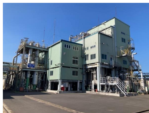
高機能性樹脂課製造プラント
