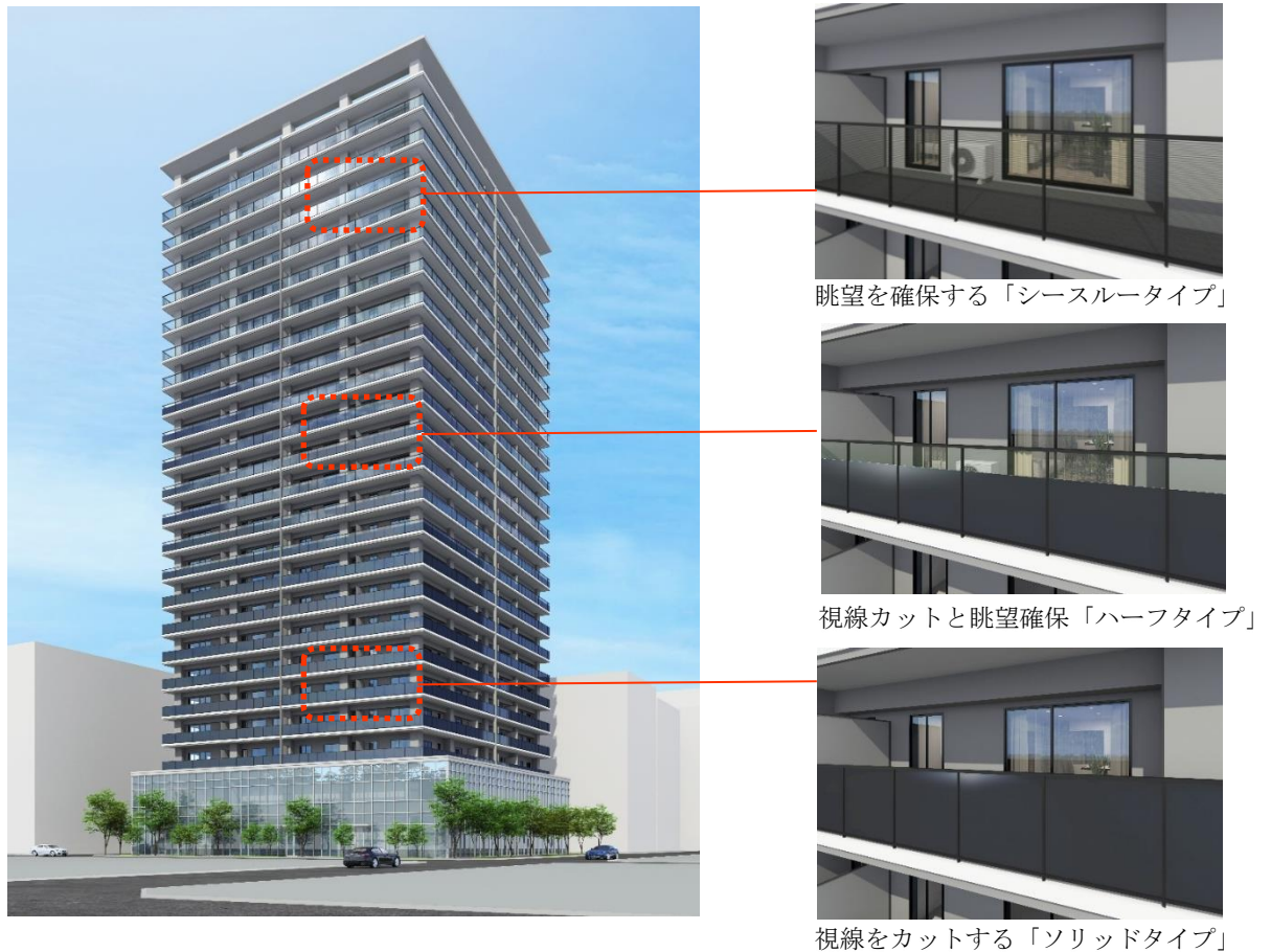
図1 超高層マンションのバルコニーで発電するガラス手摺「T-Green® Multi Solar」導入イメージ
