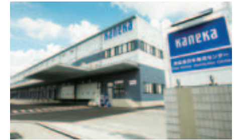
カネカ 食品東日本物流センターの外観
