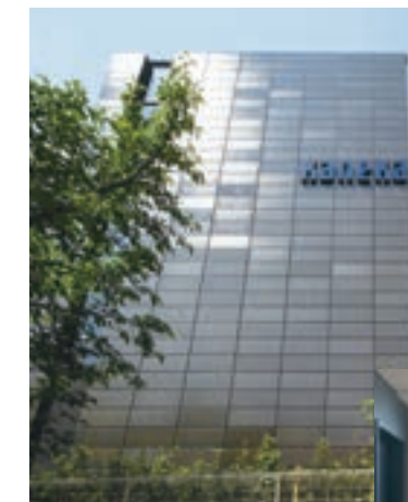
開発された壁面用の低反射型カラー太陽電池パネル
