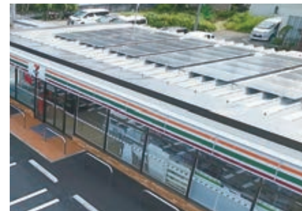
(株)セブン-イレブン・ジャパン店舗実証実験に提供された両面受光型の高性能太陽電池パネル
